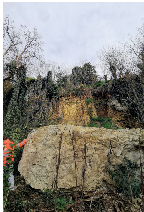
Chute de blocs sur le Lot
