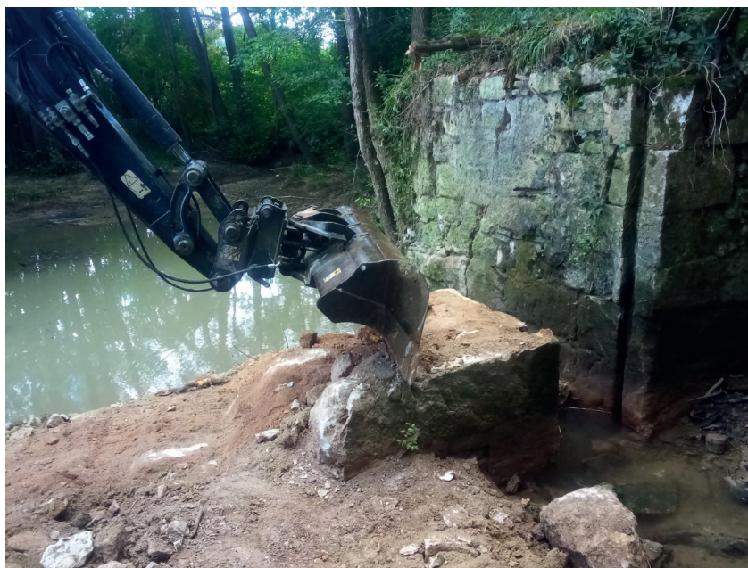
Retrait d'ouvrage sur l'Autonne à Dolmayrac avant travaux
