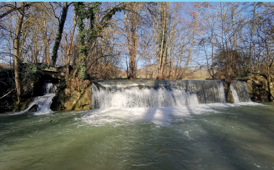
Seuils de moulins sur le Boudouyssou
