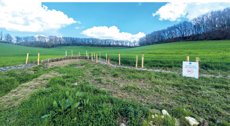
Mise en place d'une fascine et d'une haie anti-érosion protégeant une habitation, Castelmoron-sur-Lot
