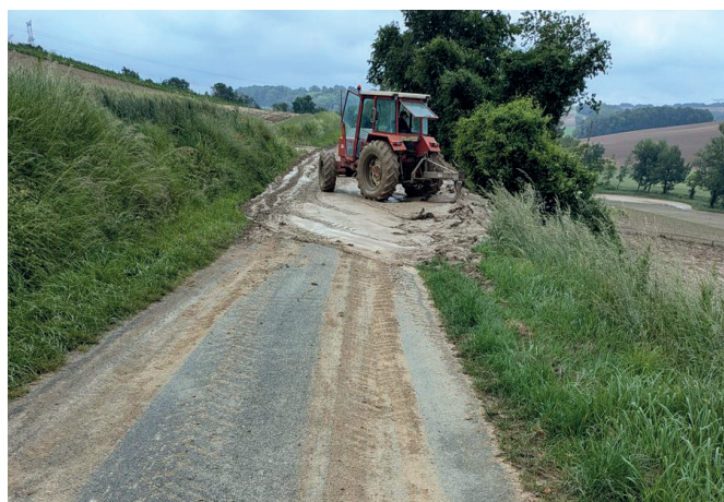
Coulée de boue sur voirie suite au ravinement d'une parcelle agricole, Saint-Salvy
