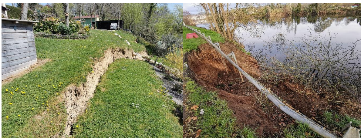
Illustration 39 : Pinel à gauche et Bourran à droite : glissement de terrain le long d'une maison et d'une route départementale
