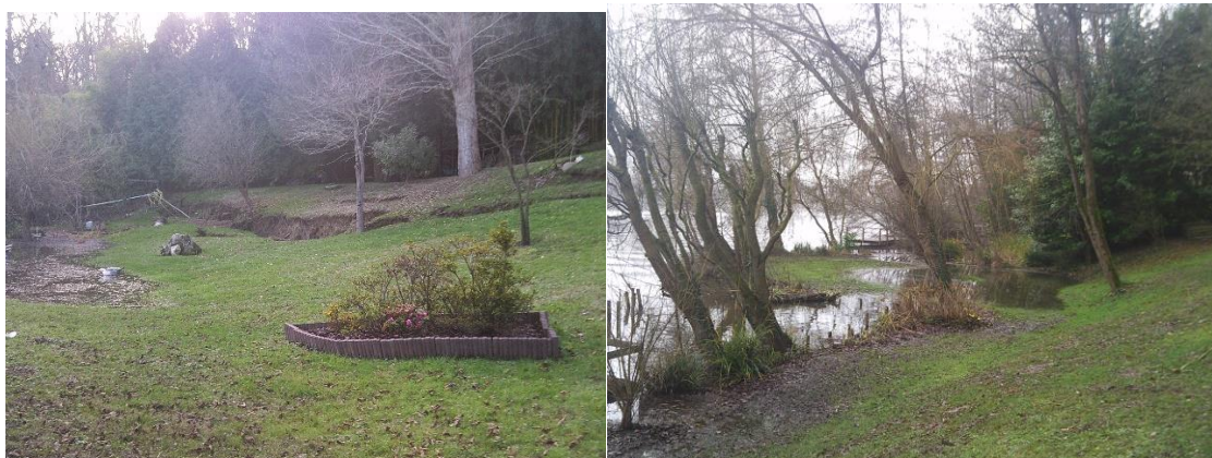
Illustration 37 : propriété de Mme Aranhic à Pinel avant et après la remise en eau du plan d'eau, janvier 2012 : fissuration du terrain, glissement global
