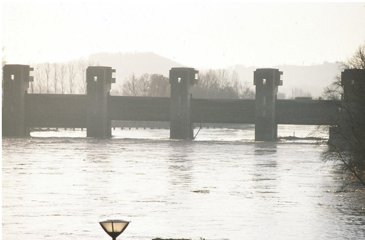
Illustration 14 : Le barrage du Temple sur Lot en 2003 : barrage effacé pour permettre le passage de l'onde de crue (toutes les vannes levées)
