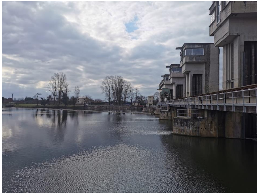
Illustration 25 : barrage du Temple sur Lot, vue de la partie amont
