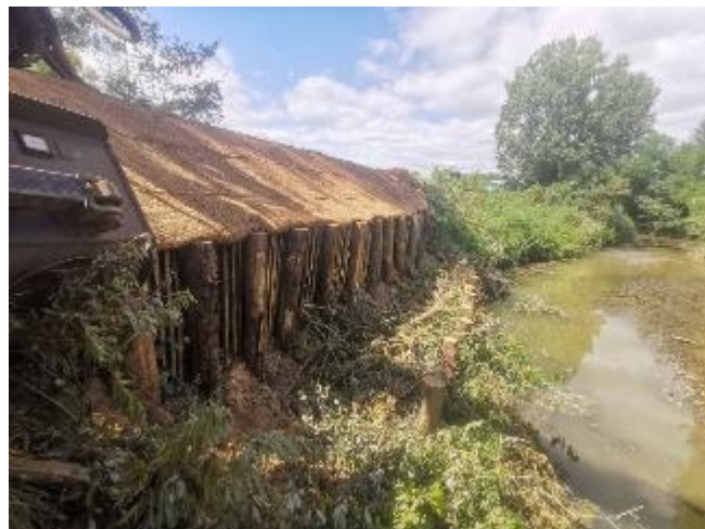
Figure 2 : exemple du confortement de berge Fauillet
