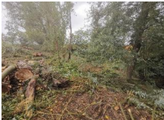
Figure 1 : Travaux de restauration sur le Tolzac en aval de Fauillet
