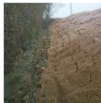
Exemple de plantation sur une protection de berge
